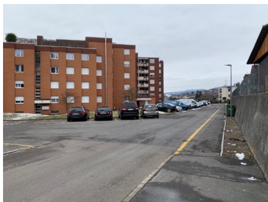
Abb. 13: Brändliguet/Langfeld, Blick entlang der Stützmauer des Werkareals. Ende des Trottoirs und Beginn des markierten Fussgänger-Bereichs
