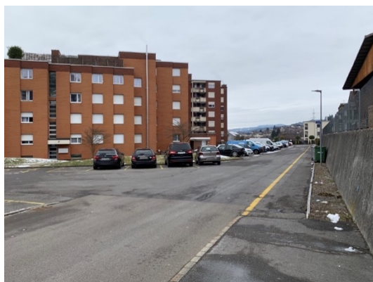
Abb. 13: Brändliquet/Langfeld, Blick entlang der Stützmauer des Werkareals. Ende des Trottoirs und Beginn des markierten Fussgänger-Bereichs
