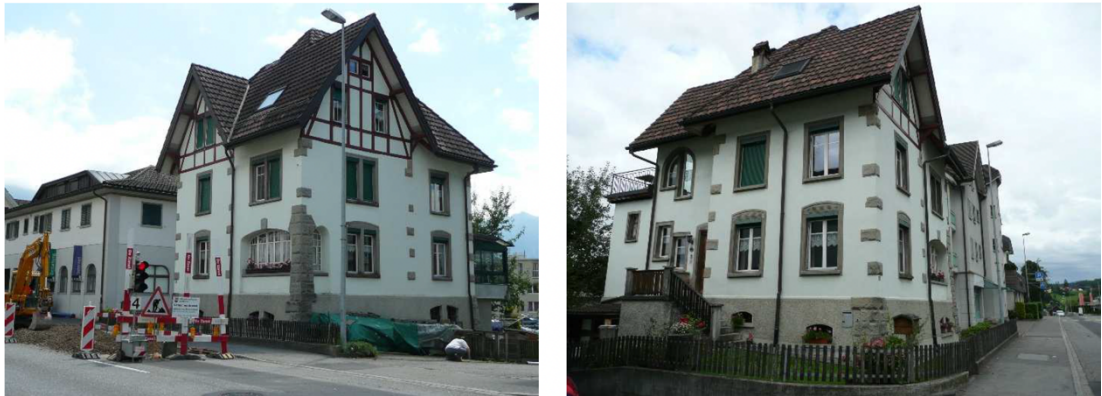
Abb. 32: Schutzobjekt Uznacherstrasse 7, GVA-Nummer 557 (Quelle: Anhang zur Schutzverordnung)
