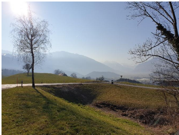
Abbildung 8: Foto Durchlass Rickenstrasse
