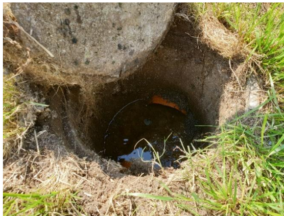
Abbildung 11: Foto Kontrollschacht eingedoltes Gewässer
