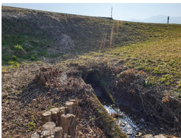
Abbildung 9: Foto Durchlass Rickenstrasse, Auslauf, Blick gegen Fliessrichtung
